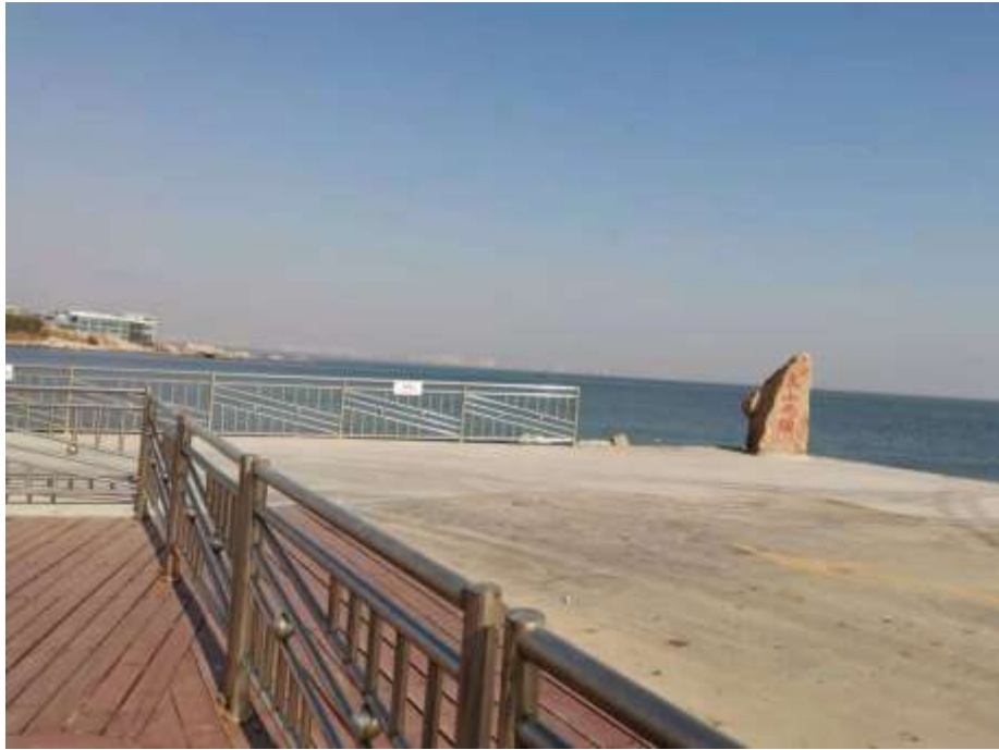
码头现场照片
