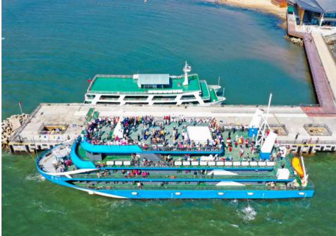
图 2.3-6c 码头建成后现场照片
