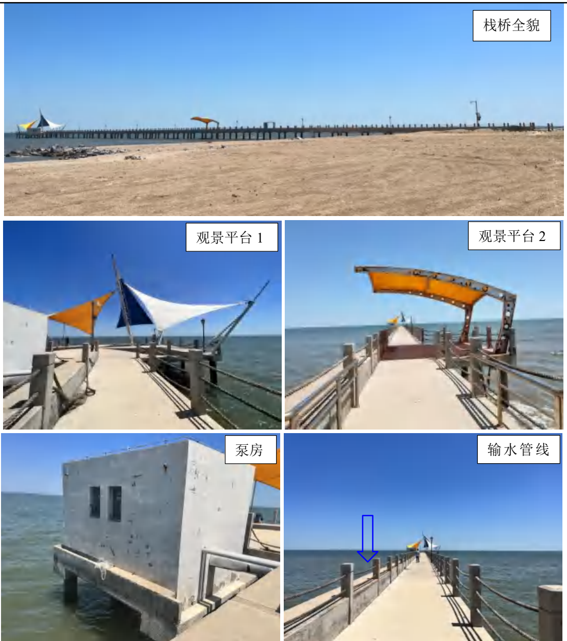
图 2-2 本项目现状照片
