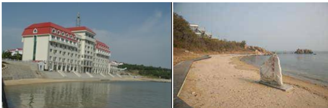
图 2.1-1 岸滩侵蚀现状图
