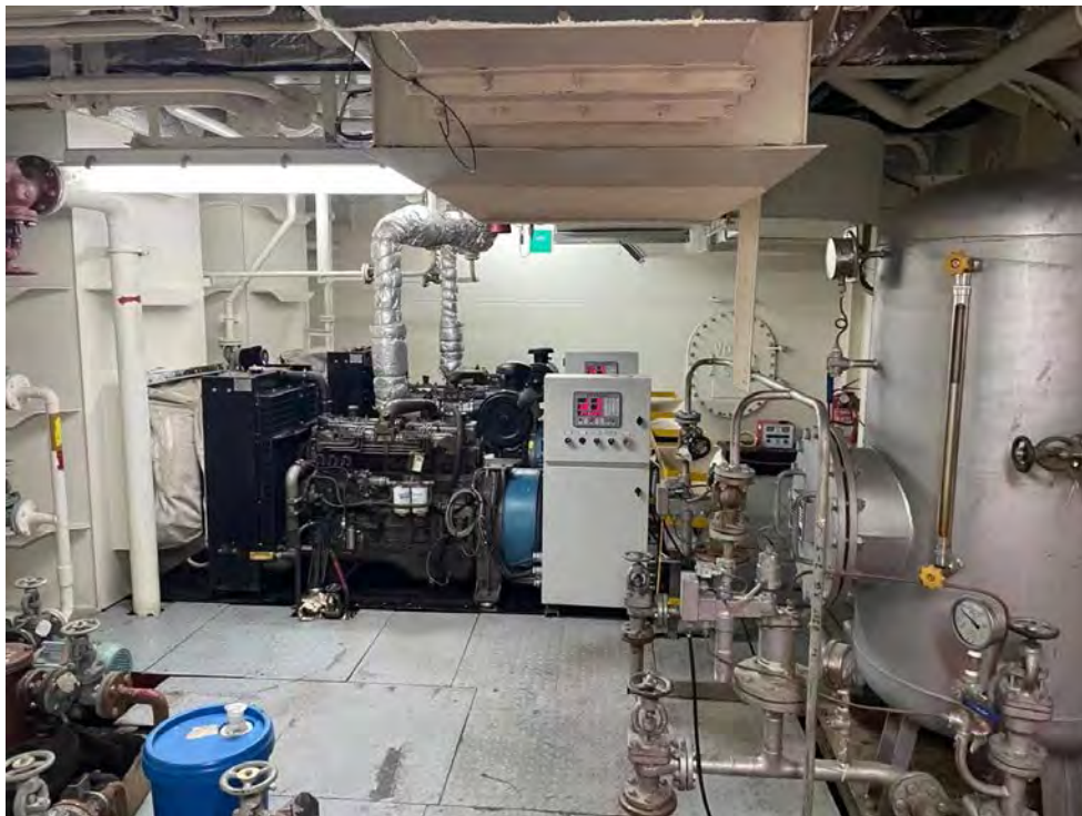
图 2.6-3 柴油发电机消音器及燃油柜
