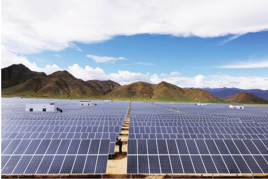
图 2.2-10 固定式光伏方阵示意图（固定支架）
