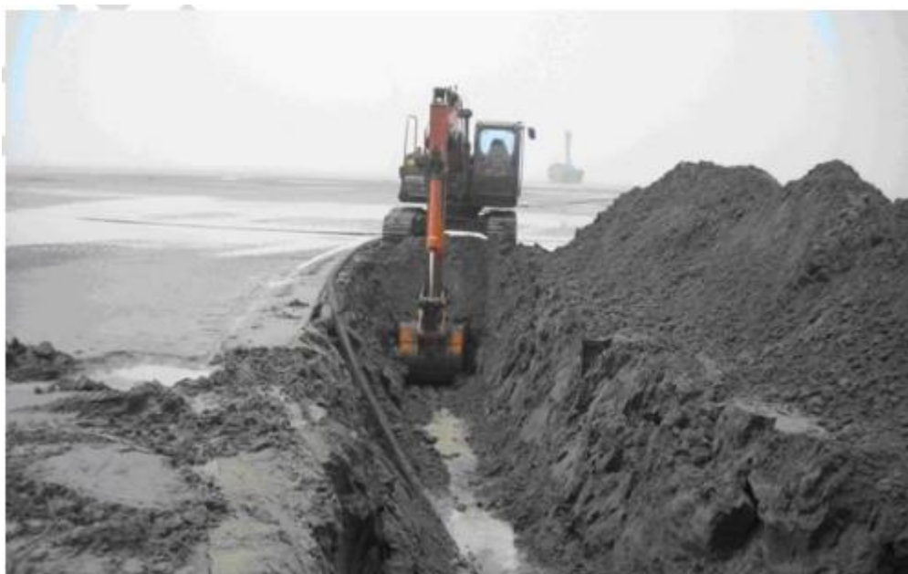
图 2.3-5 两栖挖掘机挖沟示意图
