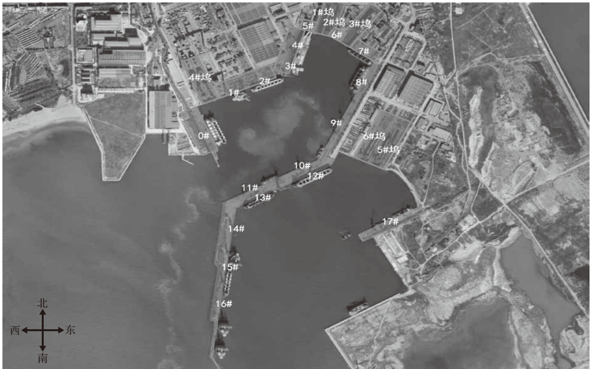
图4 山海关船厂码头、船坞口岸限定区域范围
