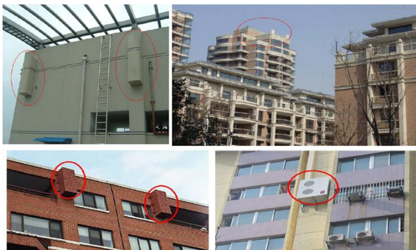
图 6-1 住宅区通信基站景观化参考
